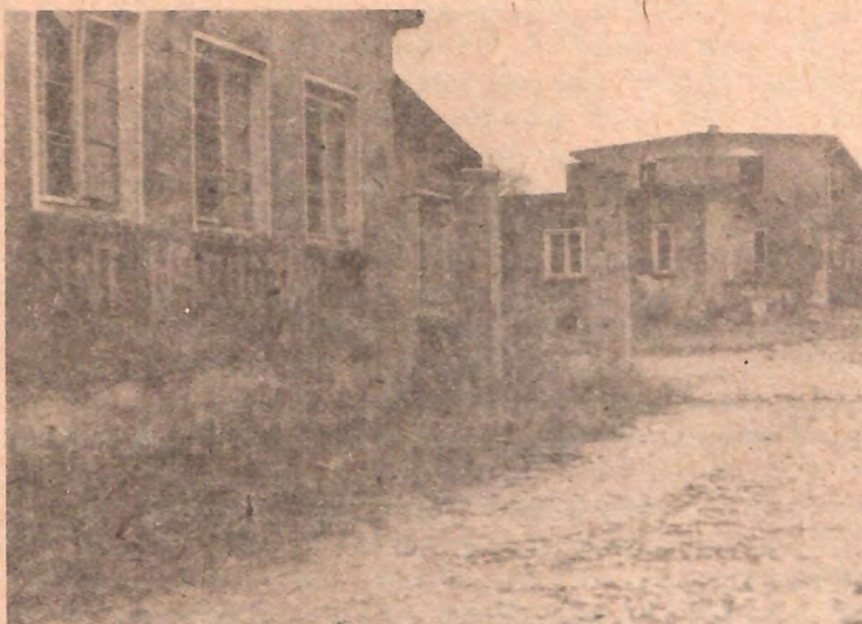
Szczyt baraku SS oraz dyżurka SS. Dalej widoczny szczyt baraku kuchni więźniarskiej. Następny budynek mieszkalny więźniów (już nie istniejące).
